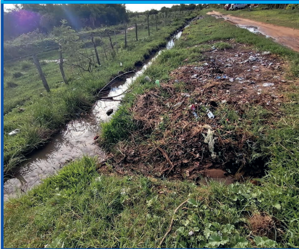
FIGURA 6: PROBLEMÁTICAS DEL BARRIO JUAN PABLO II DE PILAR. MAL DRENAJE, BARRO EN LAS VÍAS Y CONTAMINACIÓN
